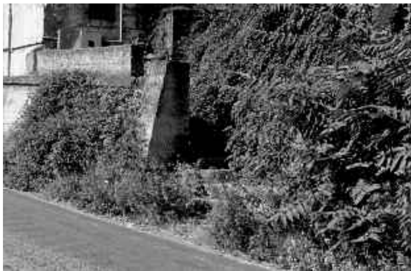
Fig. 6 - L'imbocco attuale della mulattiera principale.
