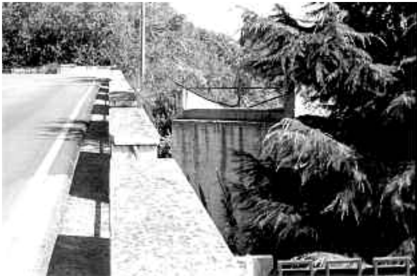
Fig. 5 - Una struttura inopportuna.
