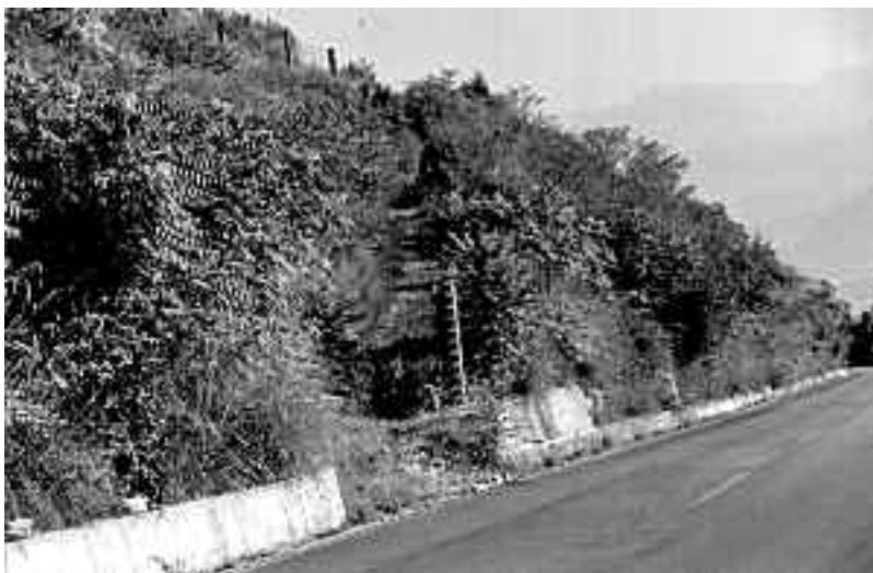
Fig. 13 - Un imbocco salvato dall'ANAS.
