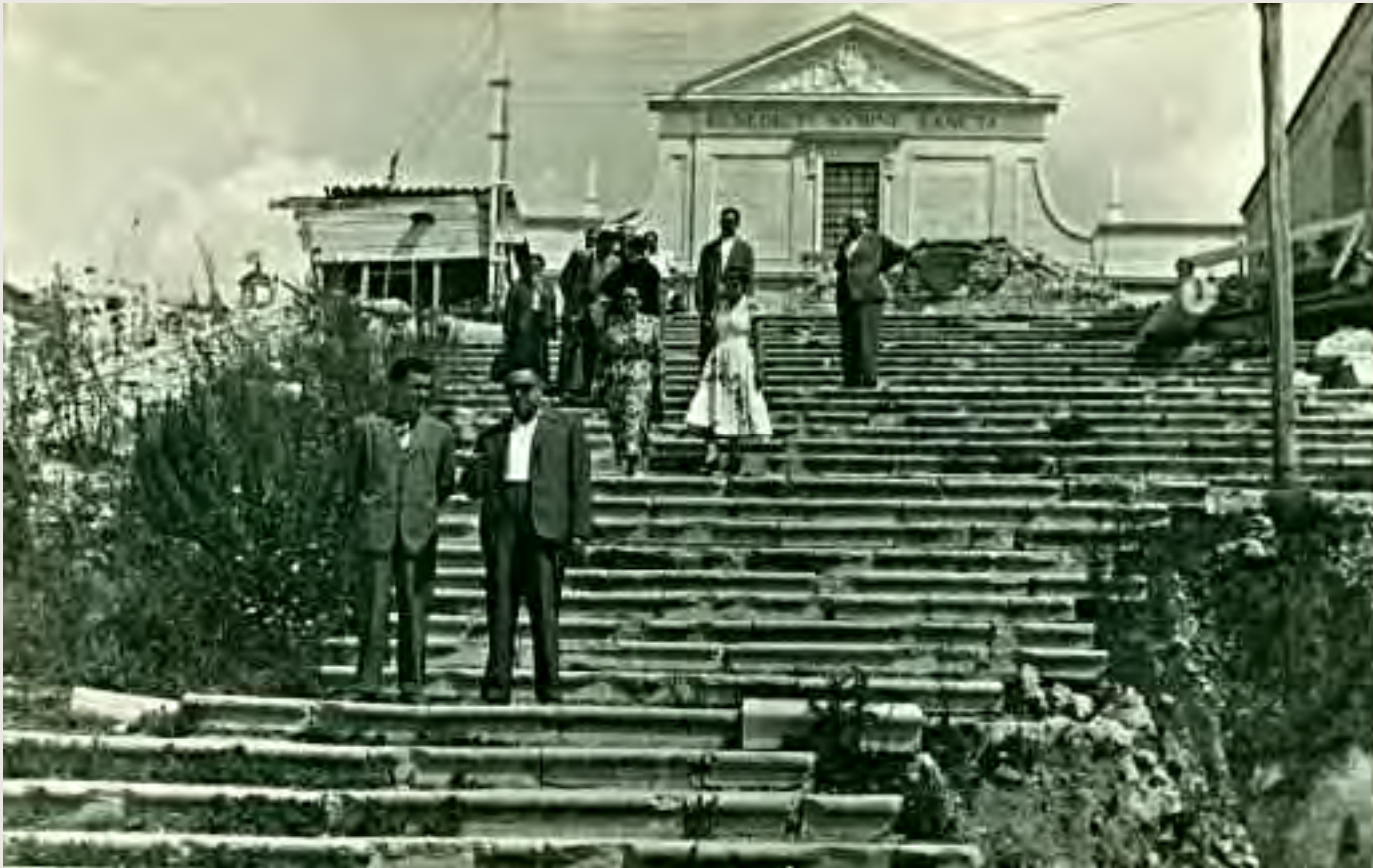
1Visita dell'ambasciatore di Germania all'abbazia di Montecassino in ricostruzione. Archivio D. Gargano
