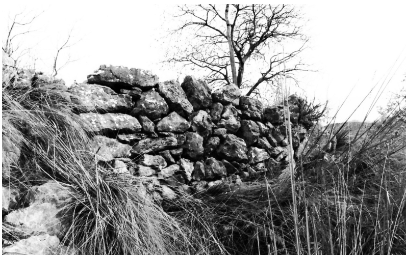
Muro a secco di contenimento a Campopiano, Comune di Belmonte Castello.
