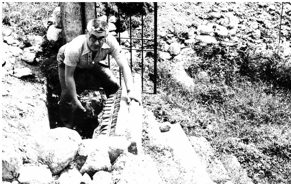
Santa Maria Maggiore: rinvenimento del pezzo di cornice.
