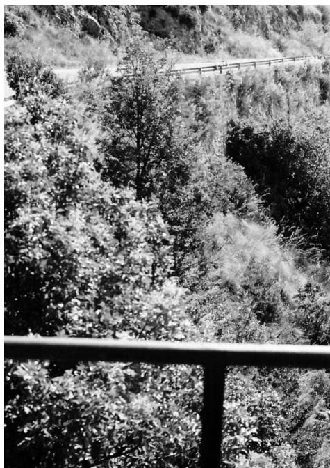
La carreggiata della strada S. Elia-Vallerotonda.
