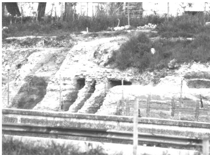
Le strutture sotterranee dell'anfiteatro di Aquinum che sfociano nella corsia di emergenza dell'autostrada. La foto, di Costantino Jadecola, è riferita ai lavori di ampliamento dell'importante arteria sul finire degli anni Ottanta.
