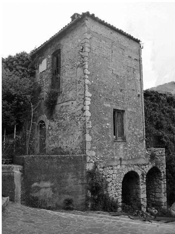
Esperia. La casa natale di Tommaso David in via del Tiglio attualmente in fase di ristrutturazione.
