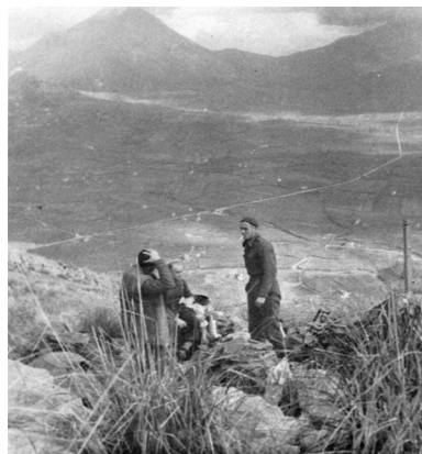
La 36 a Survey Battery sorveglia la statale Casilina da monte Trocchio.
