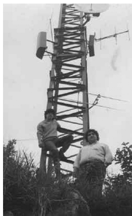
Il ponte radio montato a Roccamonfina.
