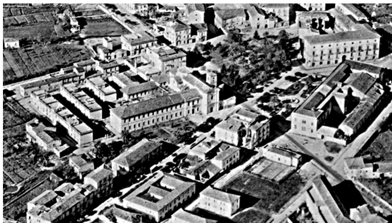
Foto del 1943. Al centro la chiesa di S. Antonio; alla sinistra le case dei ferrovieri, non distrutte dai bombardamenti; a destra il fabbricato del liceo-ginnasio e del teatro Manzoni.
